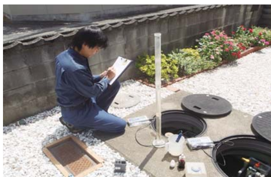
浄化槽法定検査
