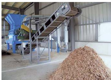
▲破碎プラント
